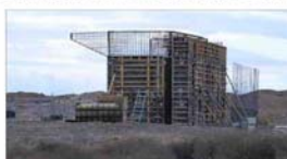
Uno de los pasos elevados sin concluir, aunque, en la A-15.
