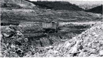
Obra de la primera fase del polígono de Valcorba.
